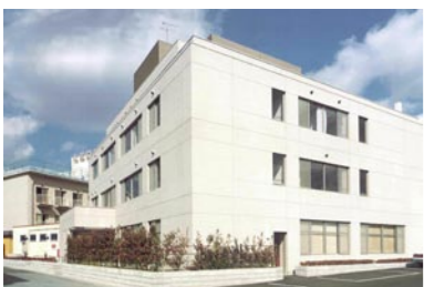
高齢化社会を見据えて、リハビリ棟を建設、専門スタッフも増員する
